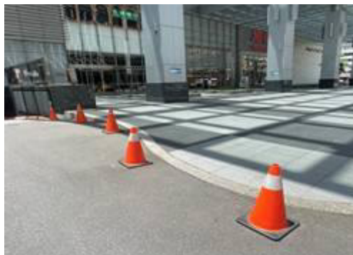
無障礙設施：西側門緩坡道
